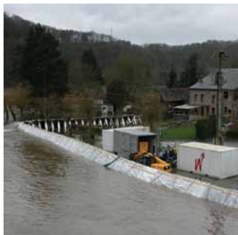
Ffigur 26. Rhwystr llifogydd ar waith, i ddiogelu mast cyfathrebu a thŷ
